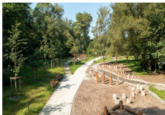
Nawierzchnie wodoprzepuszczalne (mineralne i zrębki drewniane) na terenie rekreacyjnym przy potoku Bruśnik w Leśnej (fot. Mariusz Dragan)
