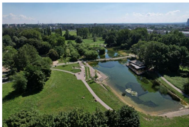
Staw retencyjny w Parku Lotników w Krakowie (fot. ZM Kraków)
