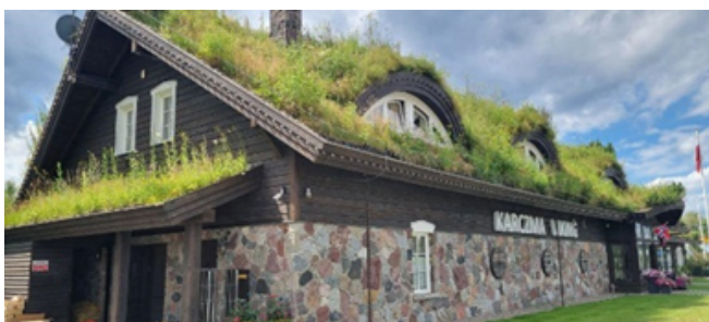
Zielony dach typu intensywnego na Karczmie Viking w Starej Kiszewie (fot. Małgorzata Siudak)
