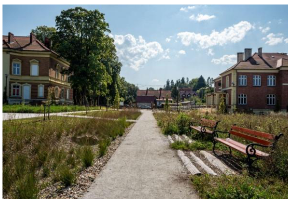
Niecka infiltracyjny oraz nawierzchnia wodoprzepuszczalna ciągu pieszego, Leśna (fot. Mariusz Dragan)
