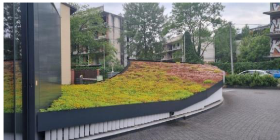
Zielony dach typu ekstensywnego na wjeździe do garażu podziemnego w Krakowie (fot. Małgorzata Siudak)
